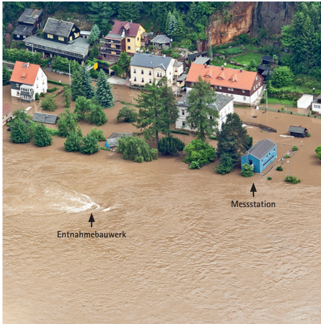
Gewässergütemessstation Schmilka – Hochwasser 2013
